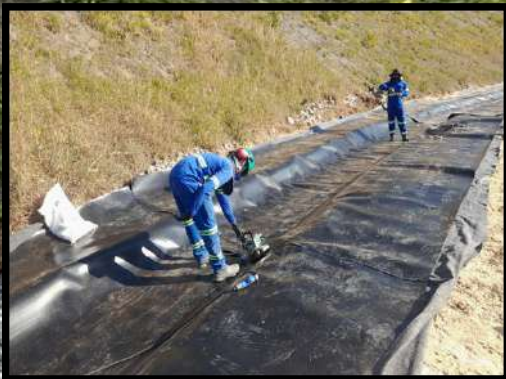
4. Instalação da geomembrana PEAD sobre o geotêxtil
