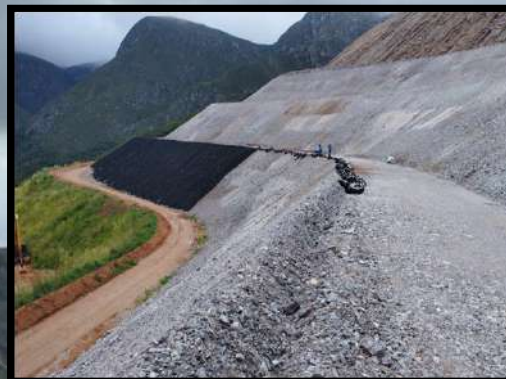
2. Execução de escavação de vala para ancoragem das geocélulas, seguida da fixação das mesmas
