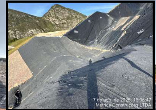
3. Instala-se os geossintéticos (geomembrana PEAD e geotêxtil) para proteção da base
