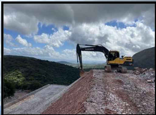
1. Execução do serviço de regularização dos taludes, conforme especificações do projeto
