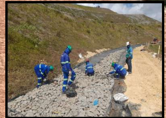
6. Aplicação e acomodação das pedras nas gaiolas instaladas
