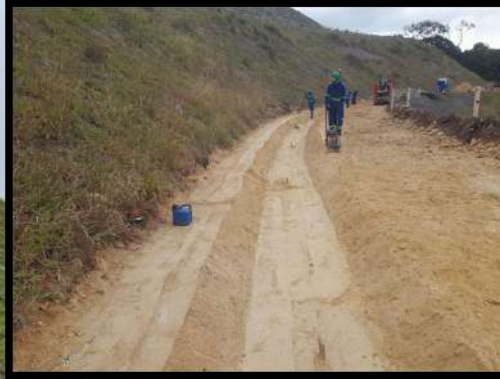
2. Regularização com argila da base escavada
