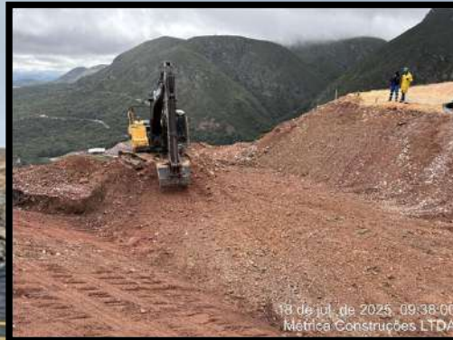
2. Após a escavação, realiza-se a regularização da base escavada
