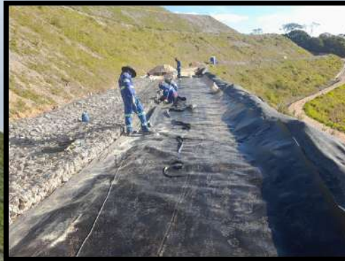
8. Aplica-se a geomembrana PEAD na berma sobre o geotêxtil
