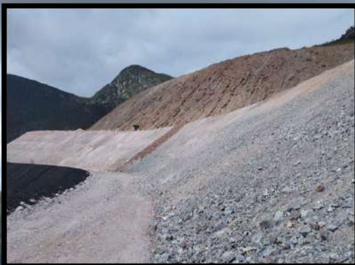
1. Execução do serviço de regularização dos taludes, conforme especificações do projeto
