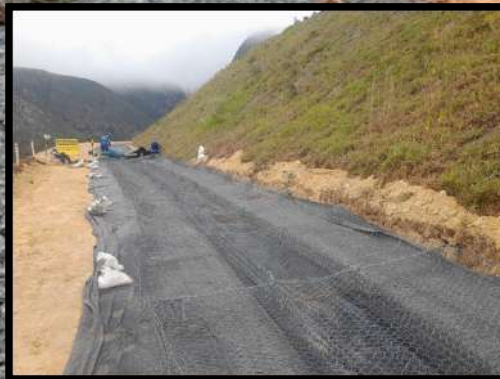
5. Pré montagem e amarração das gaiolas sobre os geossintéticos
