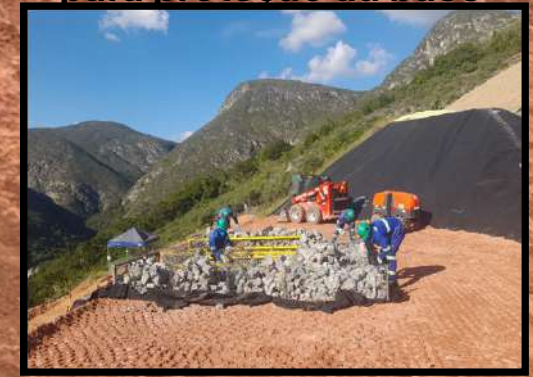
6. Procede-se à instalação das gaiolas preenchidas com pedras de mão devidamente acomodadas, visando assegurar a eficiência do sistema de drenagem
