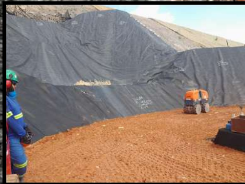
5. Ocorre a compactação mecânica, seguida da realização de ensaios técnicos para verificação do grau de compactação
