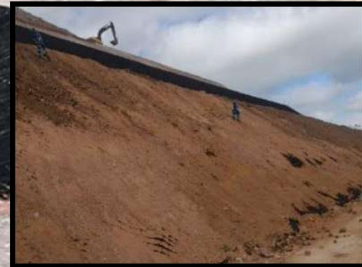
4. Concluídas as etapas anteriores, aplica-se o solo vegetal, garantindo sua acomodação colmeias das geocélulas
