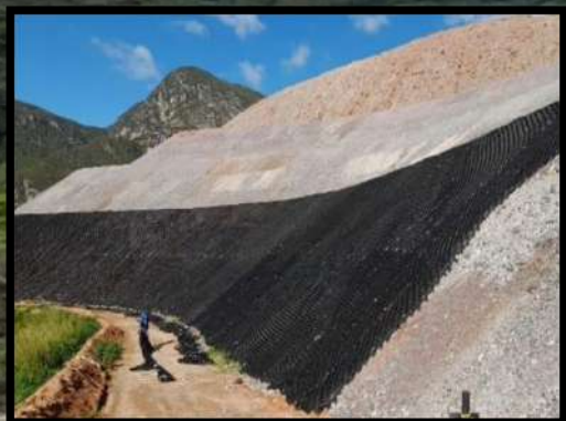
3. Após a fixação, as geocélulas são aplicadas nos taludes
