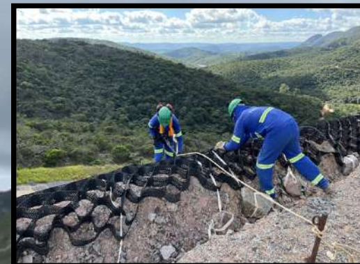
2. Execução de escavação de vala para ancoragem das geocélulas, seguida da fixação das mesmas
