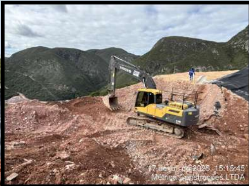
1. Realização da escavação da base do gabião
