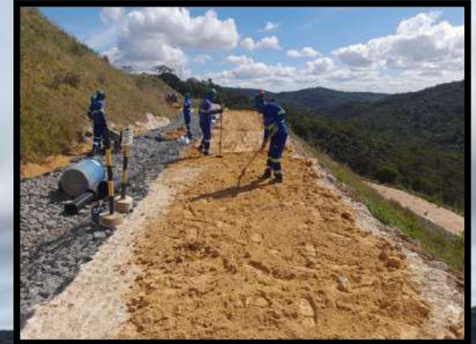
9. Após a instalação da geomembrana aplica-se argila na berma
