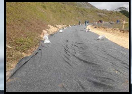
3. Aplicação de geotêxtil na base regularizada do colchão reno
