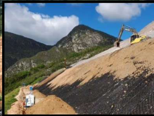
4. Concluídas as etapas anteriores, aplica-se o solo vegetal, garantindo sua acomodação colmeias das geocélulas
