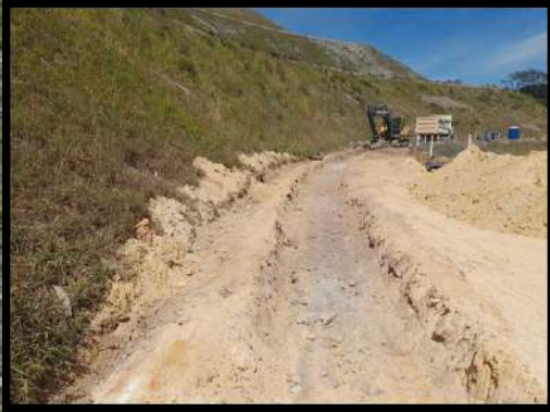
1. Execução do serviço de escavação do colchão reno
