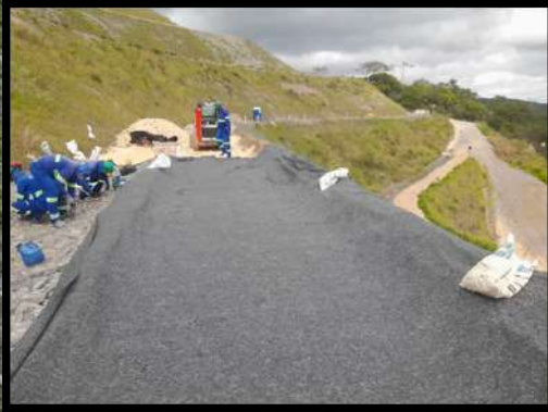
7. Instalação de geotêxtil na berma onde foi aplicado o colchão reno
