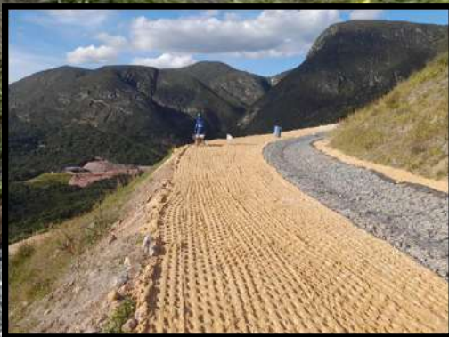
10. Após a realização de todas as atividades anteriores, utiliza o mini rolo para compactação da argila que foi aplicada na berma
