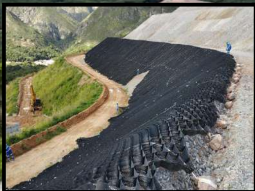
3. Após a fixação, as geocélulas são aplicadas nos taludes
